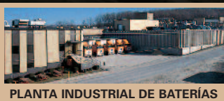
PLANTA INDUSTRIAL DE BATERÍAS
